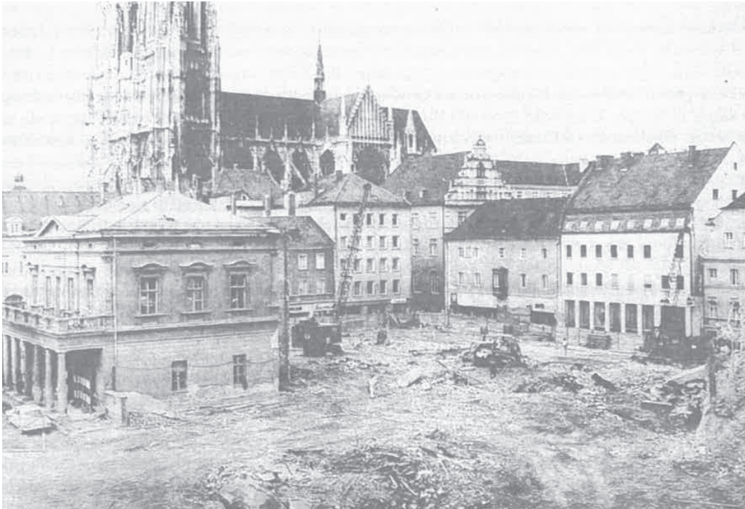
Baufeld nach erfolgreichem Abbrucharbeiten, im Vordergrund die alte Wache vor dem Teilabbruch Quelle: Söller
